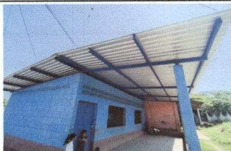
FOTO 7: PROCESO FINALIZADO DE Sustitución de estructura de soporte de madera, por metal (AULA)
