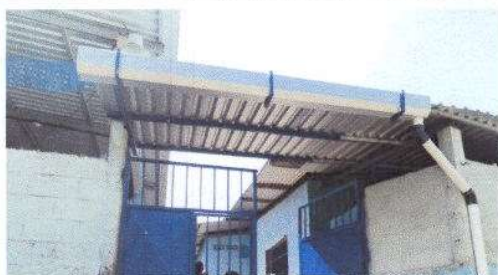
FOTO 11: PROCESO FINALIZADO DE Sustitución de canal de metal (PATIO)
