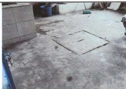
FOTO 9: PROCESO FINALIZADO DE Reparación de piso de torta de concreto (COCINA)
