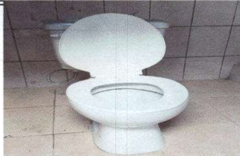
FOTO 1: PROCESO FINALIZADO DE SUSTITUCIÓN INODORO
