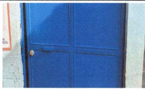
FOTO 4: PROCESO FINALIZADO DE SUSTITUCIÓN DE CHAPA (AULA)
