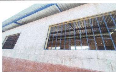
FOTO 8: PROCESO FINALIZADO DE Sustitución de balcones de metal (AULA)
