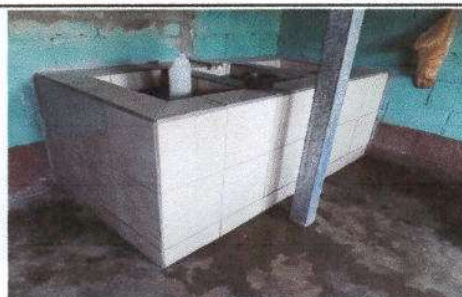
FOTO 10: PROCESO FINALIZADO DE Sustitución de Azulejo de Pila (COCINA)
