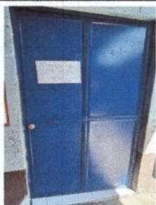
FOTO 3: PROCESO FINALIZADO DE MANTENIMIENTO A ESTRUCTURA (LIJADO, CAMBIO DE TUBO, CEPILLADO, SUJECCIONES, APLICACIÓN DE PINTURA) (AULA)
